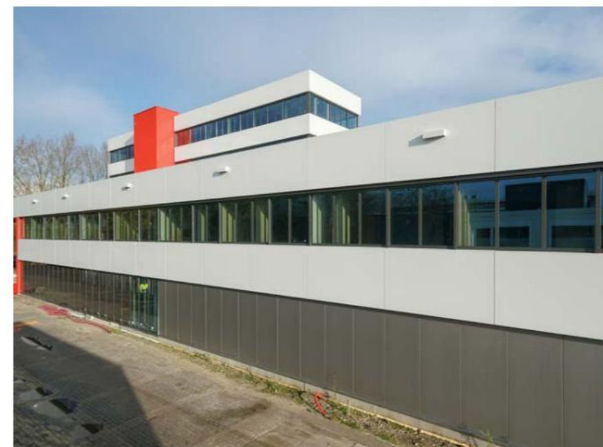
Alle gevels zijn opgebouwd met prefab HSB-elementen en een aluminium gevelcassettesysteem.
