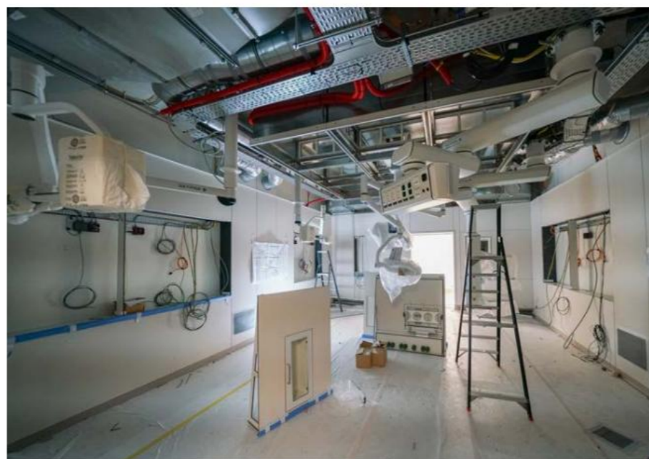
OK in de afbouwfase. Op de vloer staan enkele modulaire flexlades.
