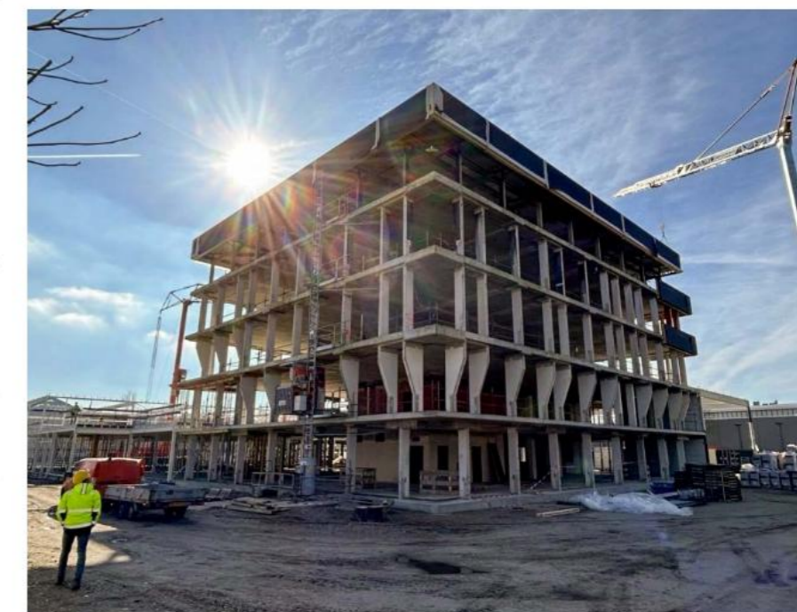
Casco van bouwdeel 2. (Beeld: Bouwcombinatie Goossen Te Pas &amp; Wessels Zeist)
